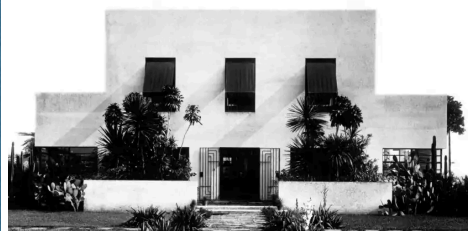
Figura 2 - Fachada Sul da Casa Modernista acabada, sem ornamentos.
