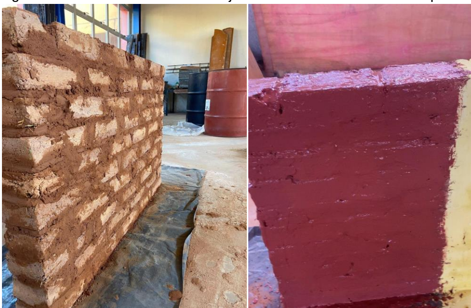
Figura 2 – Parede construída com tijolos de adobe e acabamento aplicado.
