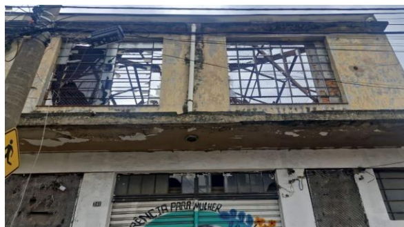
Figura 1 - Vista do telhado logo após ser demolido
