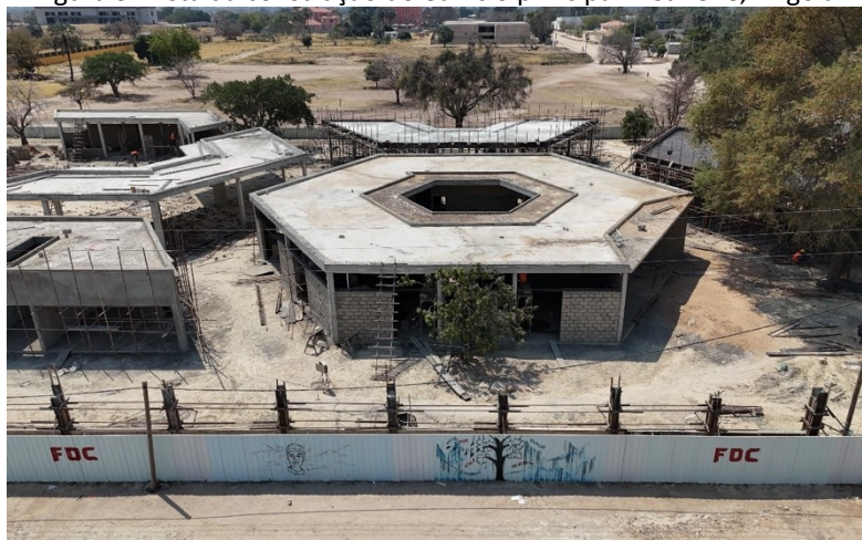
Figura 3. Vista da construção do edifício principal – Cunene, Angola.
