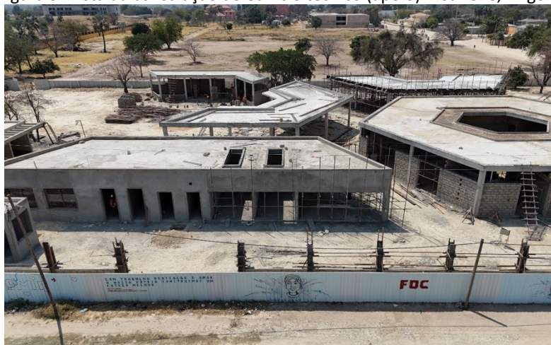
Figura 5. Vista da construção do edifício técnico (apoio) – Cunene, Angola.
