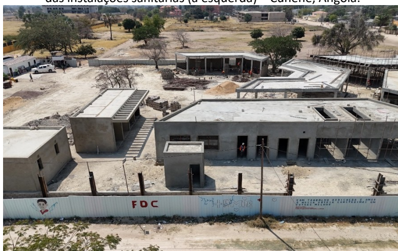
Figura 6. Vista da construção do edifício técnico e das instalações sanitárias (à esquerda) – Cunene, Angola.
