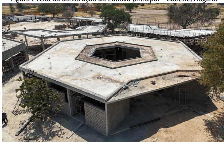
Figura . Vista da construção do edifício principal – Cunene, Angola.
