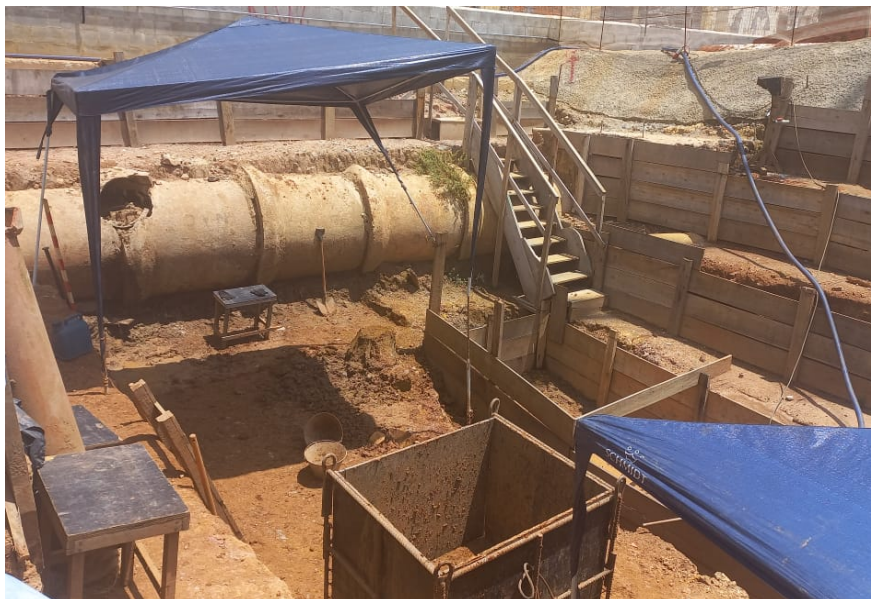
Figura 3. Sistemas de encanamento antigos, relacionados à canalização do rio Saracura. – Bairro Bixiga, São Paulo.
